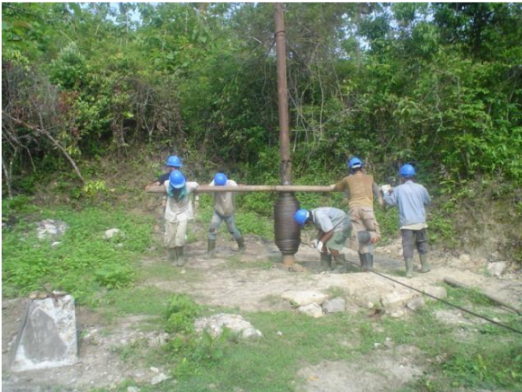
Gambar 3.7. Kegiatan re-opening Sumur Tua dengan Tombros
