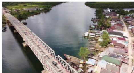
Gambar 2. Tampak atas Jembatan Gasing
