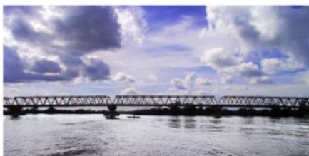
Gambar 6. Jembatan Kantilever pada Jembatan Gasing
