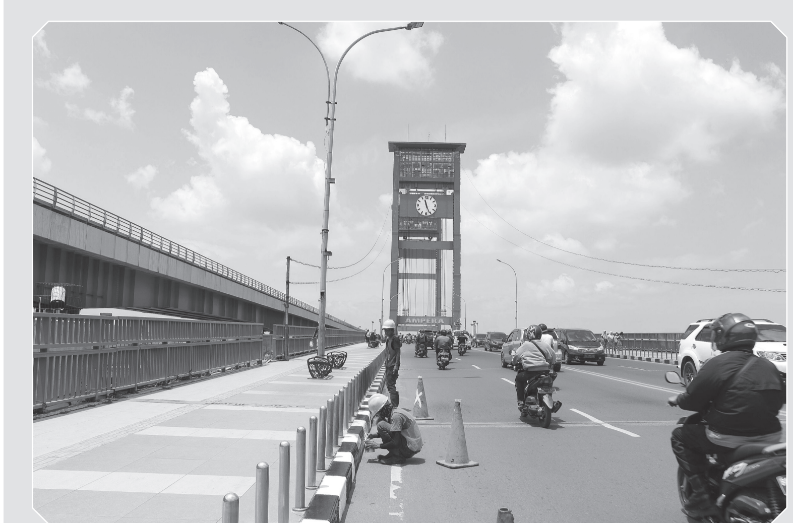
DICAT -- Pekerja mengecat zebra cross pinggir trotoar Jembatan Ampera, Senin (12/4/2021). Pengecatan ini merupakan salah satu program perawatan Jembatan Ampera agar terlihat bersih dan indah.
