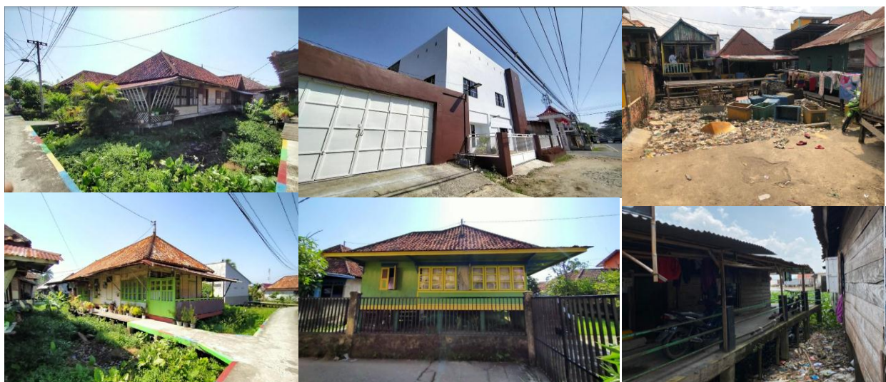
Gambar 3. Kondisi rumah dan lingkungan di Kampung Plaju Ilir: Rumah Tanpa Pagar (Kiri), Rumah dengan Pagar Pembatas (Tengah), Sampah pada Lingkungan
