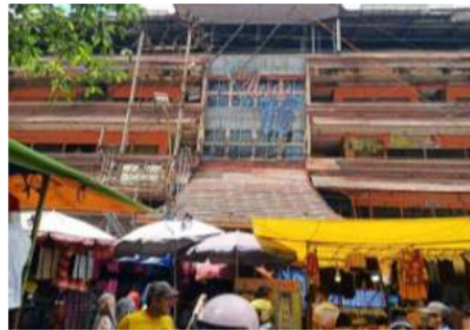
Gambar 7. Kondisi Akses menuju Bangunan yang Ditutupi Pedagang Kaki Lima di Pasar 16 Ilir Sumber: Dokumentasi Penulis, 2022
