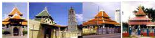
Plate 2: (Left to Right) Masjid Kampung Hulu, Masjid Kampung Keling, Masjid Tengkeri, Masjid Dato' Undang Kamat.
