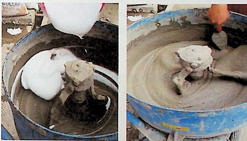
Gambar 3.19. Proses pencampuran *foam* kedalam mortar dan hasil campuran
