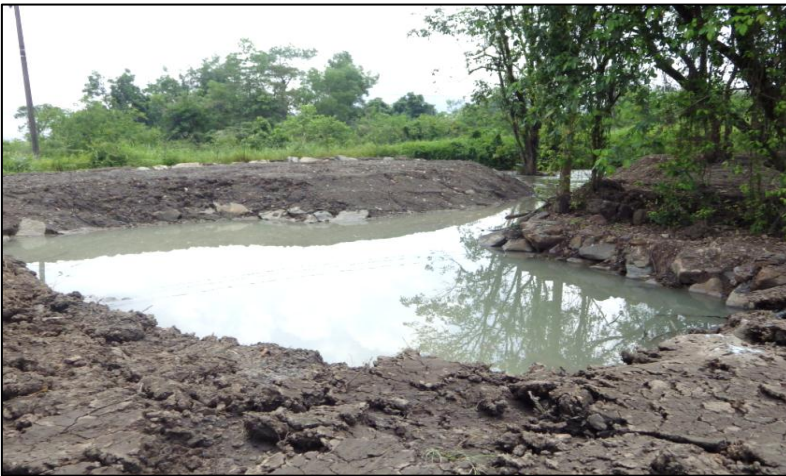
Gambar 36. Pengaliran Air Asam Tambang yang telah dinetralisir
