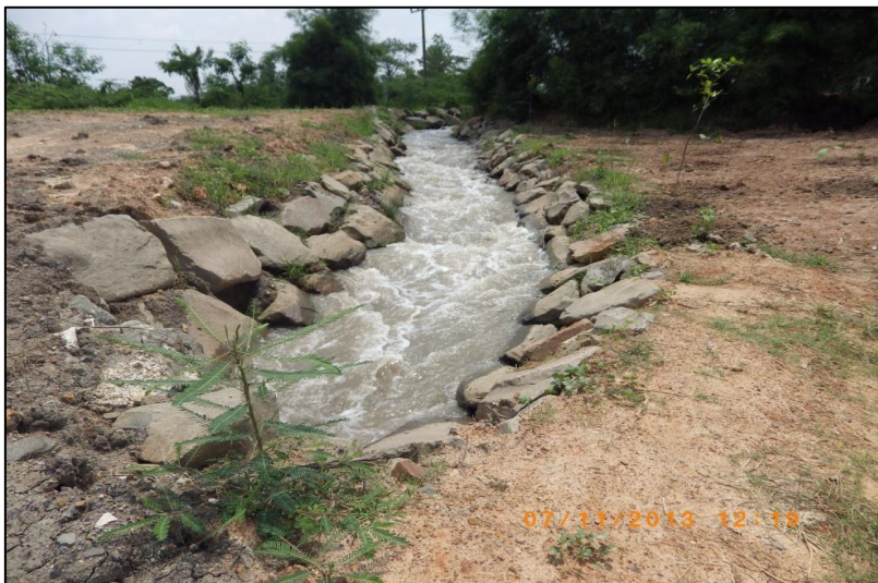
Gambar 38. Pengaliran Air Asam Tambang yang telah dinetralisir
