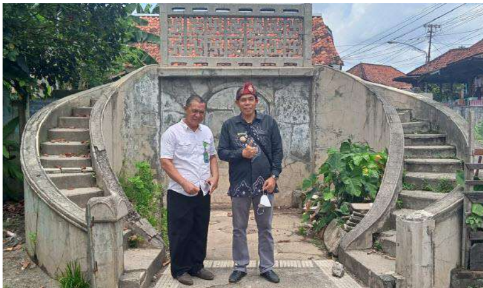
Gambar 14. Sisa Bangunan (Tangga Bagian Depan) Rumah Pangeran Danal di Kabupaten Muara Enim yang Telah Dipindahkan
