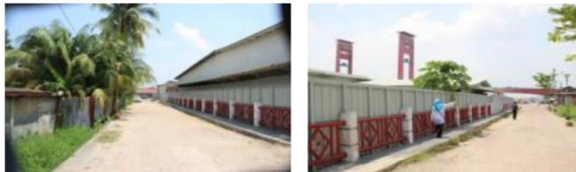
Gambar 9. Kondisi Jalur Sirkulasi Restaurant Kampung Kapitan dari sisi Kampung Kapitan
