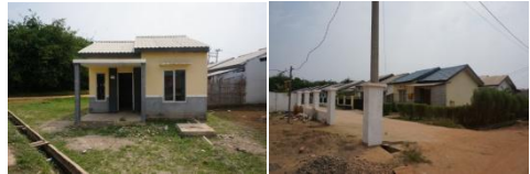
Gambar 11. Kondisi Perumahan Cipta Griya Persada Sumber : Survey Lapangan, 2014
