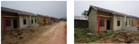
Gambar 9. Kondisi Perumahan Griya Pondok Indah Sumber : Survey Lapangan, 2014
