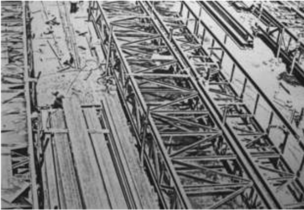
Gambar 50. Kerangka baja Jembatan Musi (Sumber: Koleksi pribadi Bapak Anwar Rifai).
