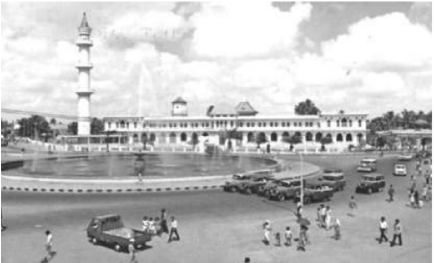
Gambar 61. Masjid Agung dan Air Mancur di tapak Jembatan Ampera Bagian Ilir Kota Palembang (Sumber: Kantor Arsip Daerah Sumatera Selatan).
