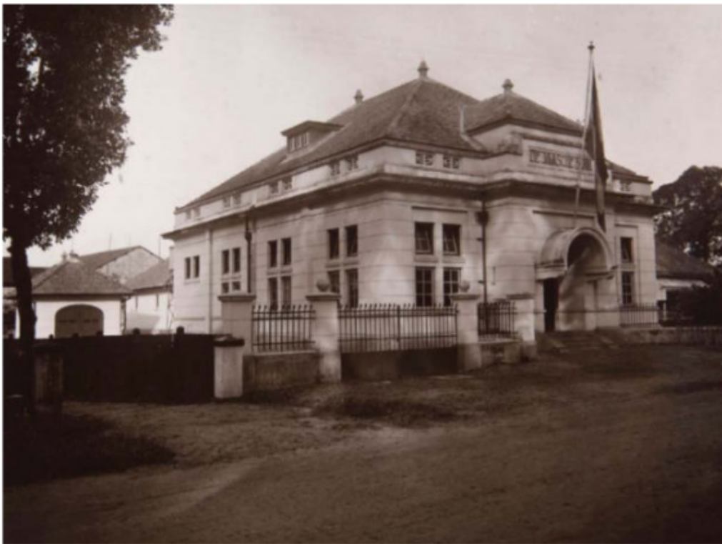
Gambar 7.32 Eksterior Gedung DJB Palembang, 1915-25
