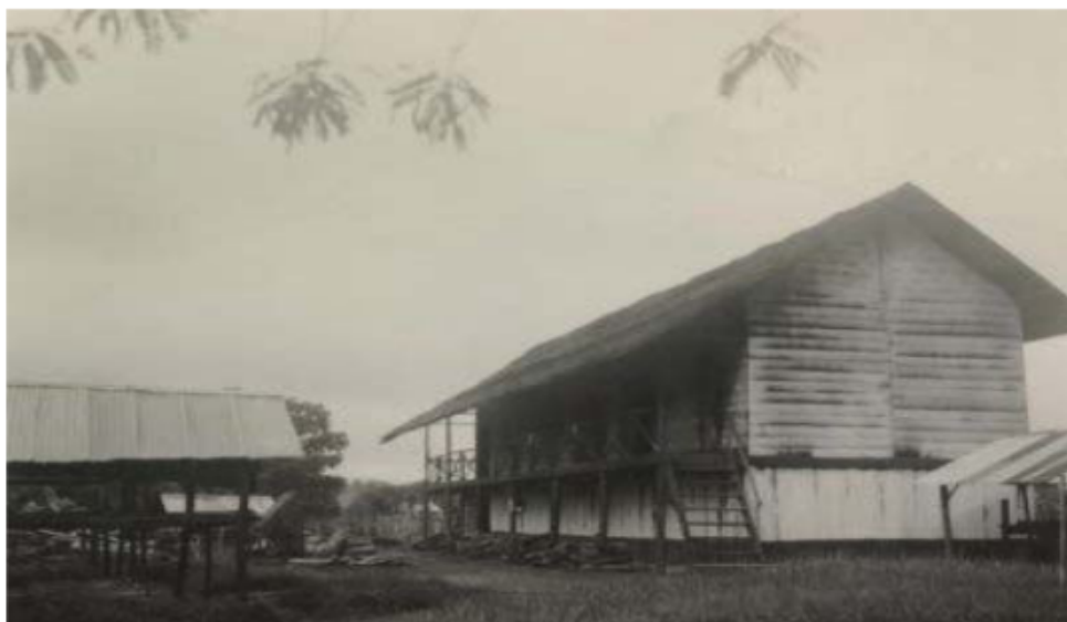
Gambar 2.5 Pabrik pengasapan karet di Tebenan, Banyuasin, 1935 (Sumber: kitlv.nl)
