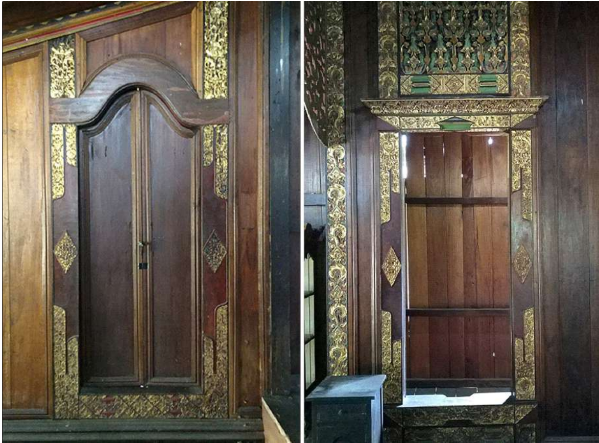
Foto 33 dan 34. Ukiran di bagian kusen pintu kamar (pangkeng). Ada juga ukiran di bagian atas pintu, berupa ukiran tembus yang berfungsi juga sebagai ventilasi.
