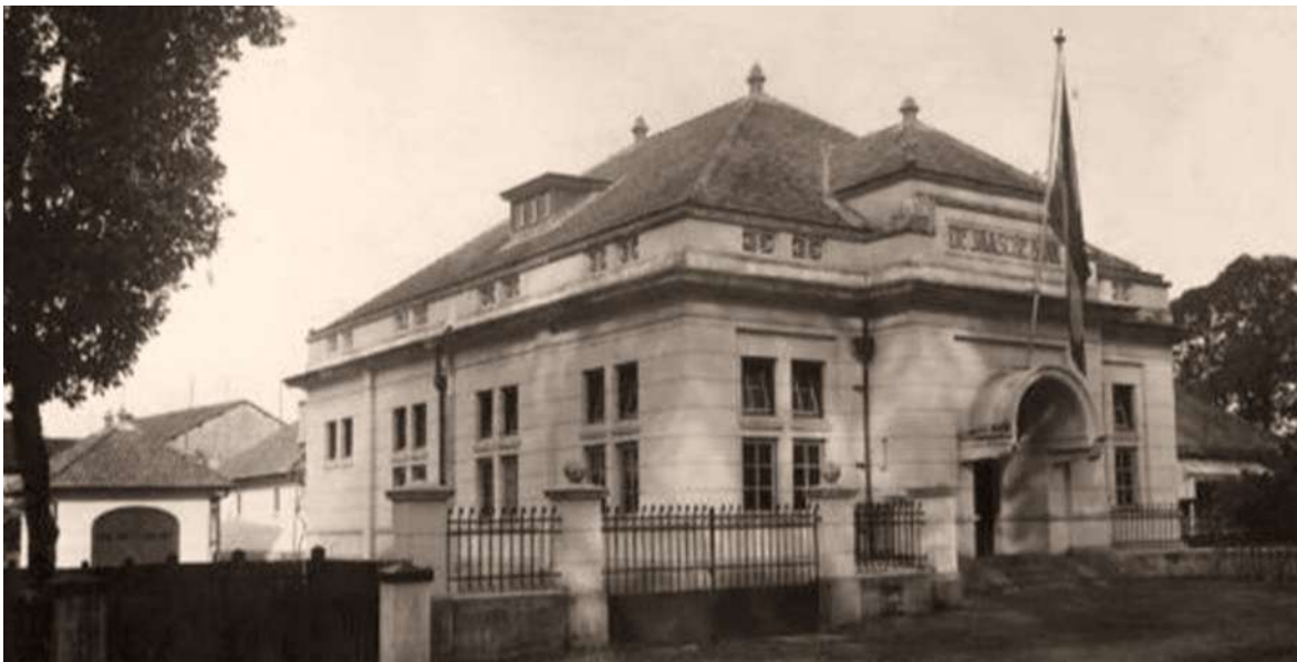
Foto 9. Gedung De Javasche Bank Palembang yang bergaya arsitektur Art Deco sumber: https://palembangdalamsketsa.blogspot.com/ , 2019
