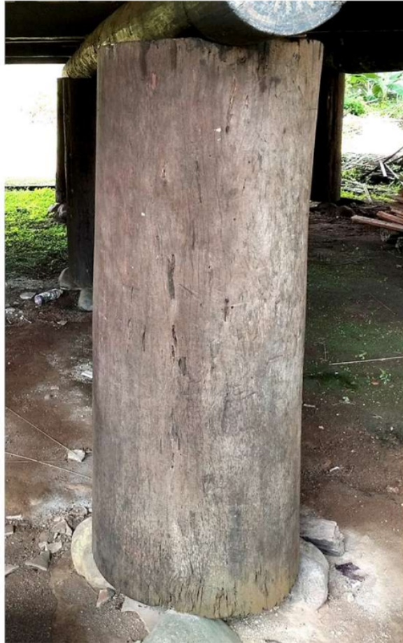
Foto 28. Tiang dan kitau rumah
