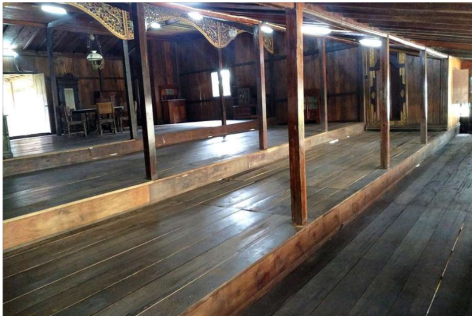
Foto 22. Ruang-ruang dan kekijing di dalam rumah limas. Tampak (dari bawah ke atas) pagar tenggalung, kekijing kiyam, dan sebagian ruang gajah.
