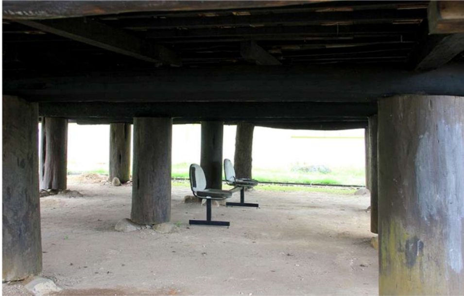
Foto 36. Tiang rumah yang tidak ditanam di tanah, tetapi ditopangkan di atas batu membuat konstruksinya lentur.
