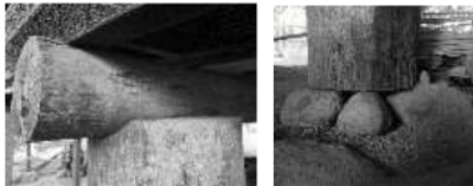
Gambar 6. Detail Struktur Lapis Bawah Lamban Ulu Ogan Sumber : Analisa
