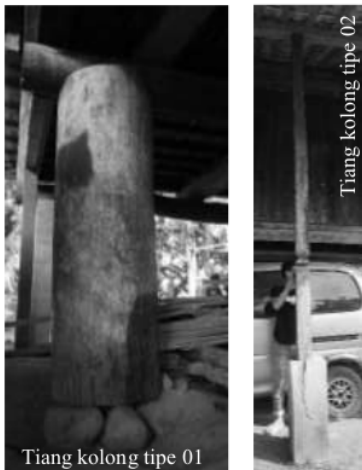
Gambar 7. Tipe Tiang Kolong Sumber : Foto Pribadi
