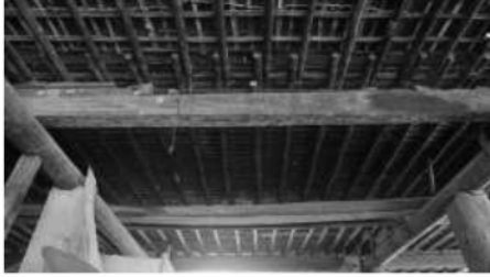
Gambar 9. Struktur rangka dan penutup lantai Sumber : Foto pribadi
