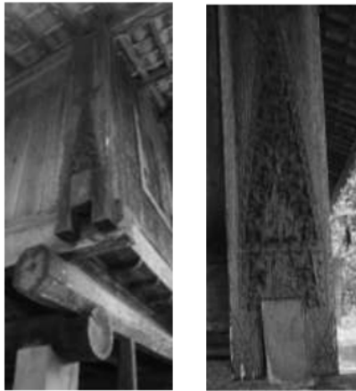
Gambar 10. Tiang utama rangka rumah Sumber : foto pribadi
