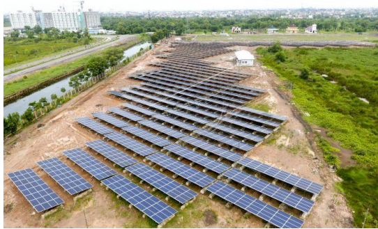
Gambar 3. 1. Lokasi PLTS 2 MW Jakabaring
