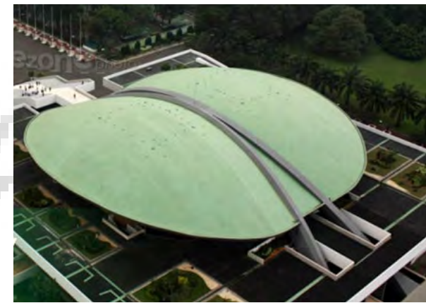
Struktur atap gedung DPR-RI: beton pra-tegang
