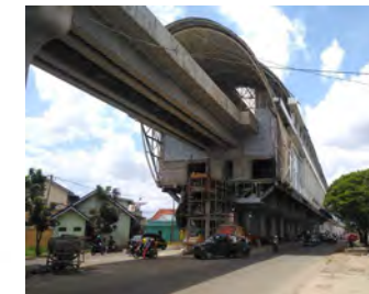
Struktur komposit baja profile + beton pada hybrid pier jalur LRT, Palembang
