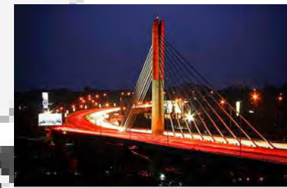
Struktur beton pra-tegang pada gelagar Jembatan Pasupati, Bandung
