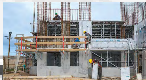
Struktur beton bertulang
