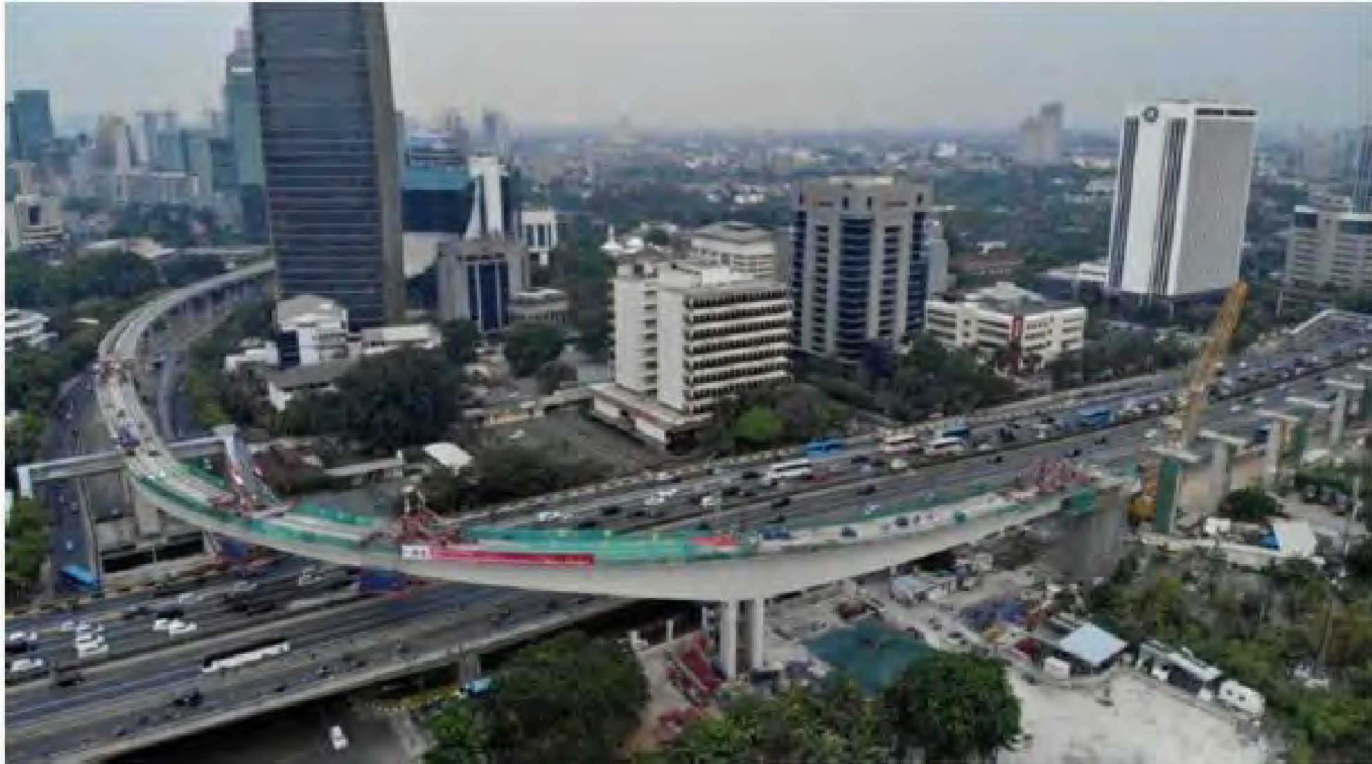
Long Span LRT Kuningan, Panjang 148 meter di atas flyover
