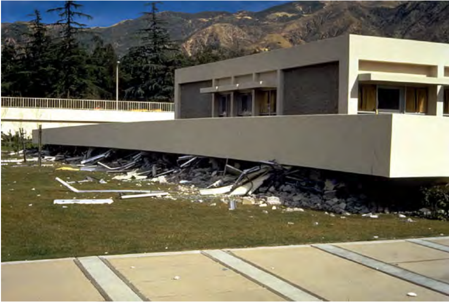
Olive View Hospital, Unit Psikiatri, gempa San Fernando, tahun 1971. Unit ini adalah bangunan beton bertulang 2 lantai. Lantai dasar hancur. Sistem struktur adalah rangka pemikul momen. Sumber: db.world-housing.net
