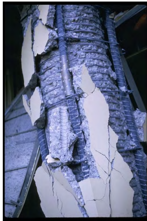
Detil kolom dengan sengkang baja spiral (pengekang beton). Sengkang tersebut mempertahankan keutuhan inti beton. Tulangan longitudinal terikat di bagian luar sengkang spiral, sehingga rentan rusak. Image credit: EIS-Steinbrugge
