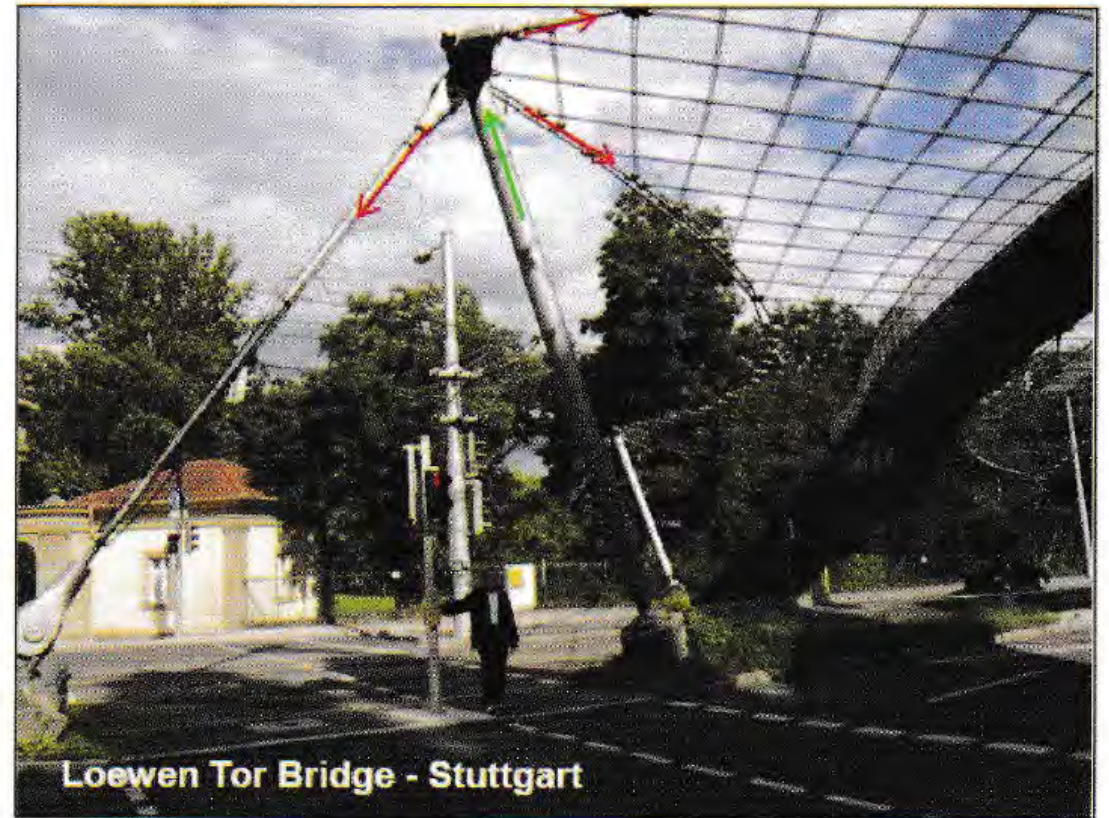
Gambar 1-8: Strut-and-tie pada struktur kabel (Sumber: Hardjasaputra H. [24])
