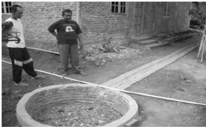
7/18/2012 Gambar 2. Contoh sumur resapan di halaman rumah tinggal 184
