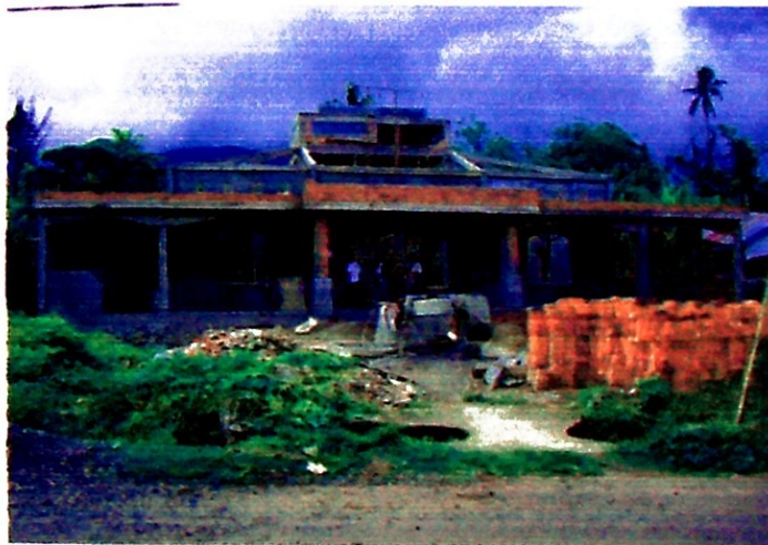
Gambar 1.2 Rekonstruksi bangunan masjid di desa Sadan Kecamatan Jarai Kabupaten Lahat yang akan dianalisis strukturnya.
