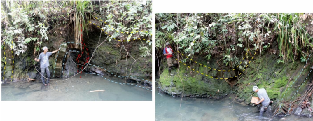
Gambar 9.5. Lokasi proyek 5. Kegiatan di sini mengevaluasi struktur di sungai Pino Pentaring yang mengalir ke wilayah Tanjung Sakti, Sumatera Selatan, kemudian membuat laporan tertulis yang dilengkapi dengan lampiran hasil pemodelan struktur di lokasi proyek.
