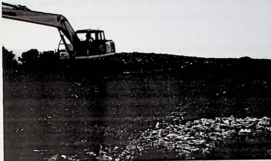
Gambar 2.1 Aplikasi Tanah Penutup Akhir di TPA I Sukawinatan.
