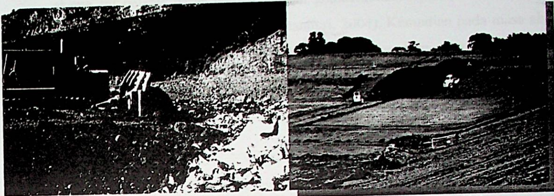
Gambar 2.3 Aplikasi penutup harian pada sanitary landfill
