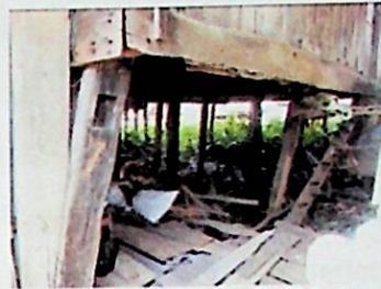
Gambar 1.1 Kondisi tiang rumah di kelurahan 3-4 Ulu Sumber: Dokumentasi pribadi, 2014
