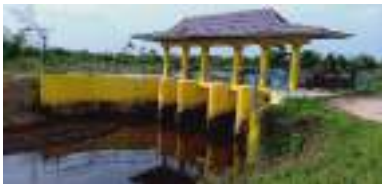
A (Pintu air saluran primer)
