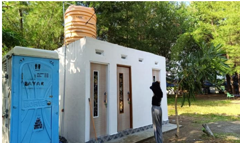
Gambar 3.7. Bangunan Toilet dan Kamar Bilas
