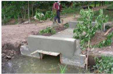
Gambar 7. Model pintu air yang sesuai dikembangkan di lahan tipe C merubah kelas drainase dari dalam menjadi dangkal
