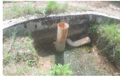
Gambar 7. Model pintu air yang sesuai dikembangkan di lahan tipe C merubah kelas drainase dari dalam menjadi dangkal
