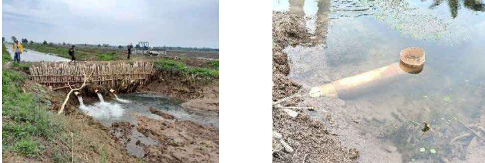
Gambar 10. Kondisi DAM di saluran sekunder drainase (SDU) untuk menaikkan muka air tanah (tahun 2021)
