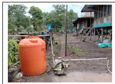
Gambar 4. unit pengolahan air untuk mengatasi kekeruhan dan pH air yang rendah.
