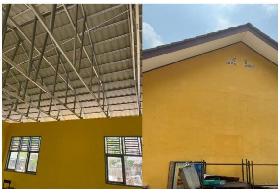
Gambar 3. Kondisi Ruang Kelas setelah di Renovasi
