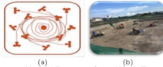
Gambar 1. Pemasangan kincir (a) Pengaturan formasi kincir (Tampangallo et al., 2014) (b) Pemasangan kincir PWA 1 HP, central drain dan pipa outlet
