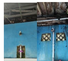
Gambar 4.39 Keadaan Shower Pada Ruangan Toilet Kedua
