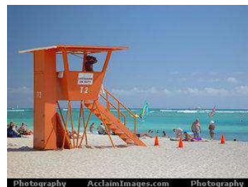
Gambar 2.9. Tower Penjaga Pantai Jenis III
