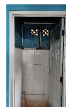
Gambar 4.36 Keadaan Toilet Sekaligus Kamar Ganti kedua
