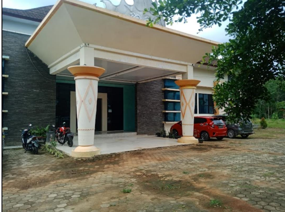
Gambar 4.8 Gedung Dinas Pariwisata Kabupaten Pesawaran
