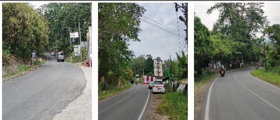
Gambar 4.12 Kondisi Marka Jalan di Kawasan Pantai Mutun
