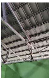
Gambar 4.31 Ventilasi Pada Ruang Toilet Pertama
