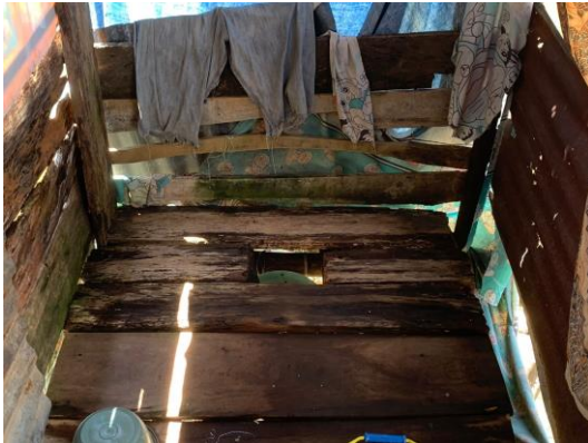
(Kondisi Sarana Pembuangan Tinja)
