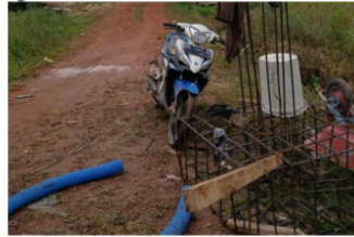
Gambar 10. Pondasi Ceker Ayam Sumber: Dokumentasi Pribadi
