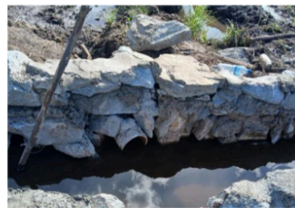
Gambar 8. Pembangunan Saluran Pipa Sumber: Dokumentasi Pribadi
