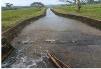
Gambar 5. Saluran Irigasi Sekunder di Lahan Sawah Desa Banyuasin Sumber: Dokumentasi Pribadi
