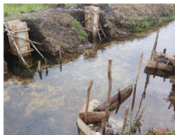
Gambar 9. Pekerjaan Jembatan Bentang 4 Meter Saluran Irigasi Sumber: Dokumentasi Pribadi
