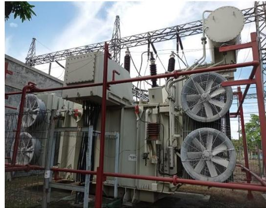
Gambar 2. Bay Trafo 60 MVA 11.5/150 kV GT 1.2 di ULPL Indralaya
