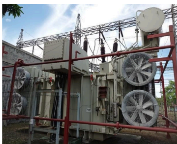
Gambar 2. Bay Trafo 60 MVA 11.5/150 kV GT 1.2 di ULPL Indralaya
