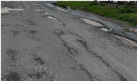
Gambar 1. 1 Kondisi Ujung Jalan
