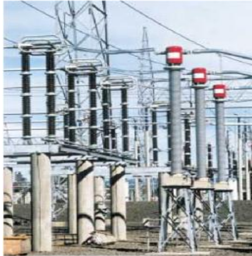
Gambar 4-4 : Tipikal Gardu Hubung 115 kV dengan VT yang terpasang diatas pipa setinggi 10 ft
