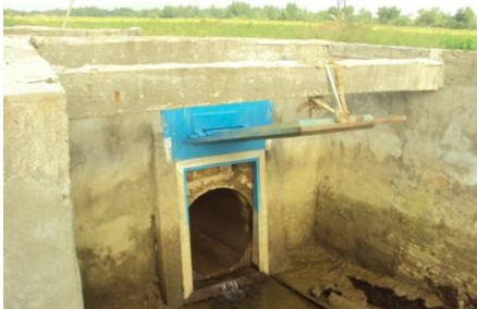
Gambar 8. Pintu air tipe ayun untuk di level tersier
