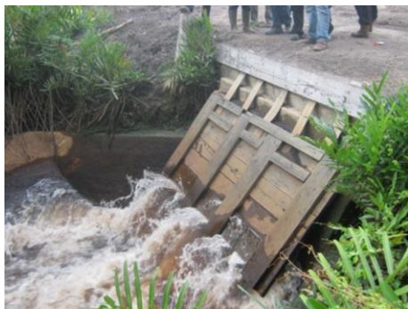
Gambar 7. Pintu air tipe kelep berbahan baku lokal untuk pengendali muka air di sekunder (Imanudin, 2011)
