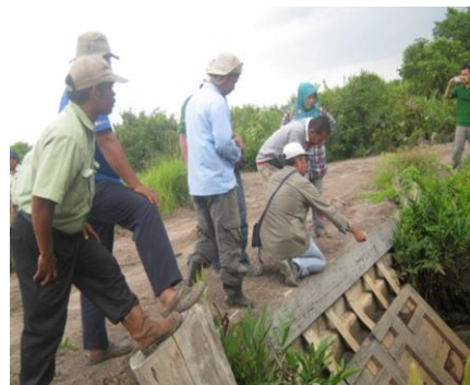
Gambar 7. Pintu air tipe kelep berbahan baku lokal untuk pengendali muka air di sekunder (Imanudin, 2011)
