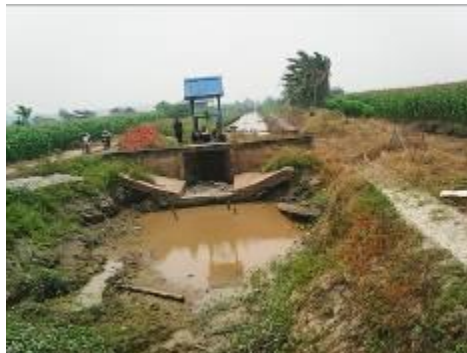
Gambar 6. Pintu air sekunder tipe ulir, operasi di tutup dan dilengkapi bangunan tambahan dam permanen pada hilir pintu untuk tinggi jagaan air minimal.
