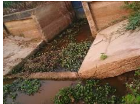
Gambar 6. Pintu air sekunder tipe ulir, operasi di tutup dan dilengkapi bangunan tambahan dam permanen pada hilir pintu untuk tinggi jagaan air minimal.
