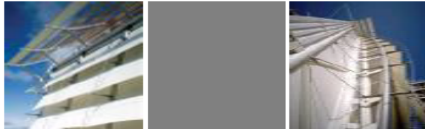
BAGIAN SISI UTARA & SELATAN DITUTUP MEMBRAN DARI BAHAN POLYESTER FABRIC SERTA DILAPISI PVC, SEMENTARA RANGKANYA DARI BAJA
