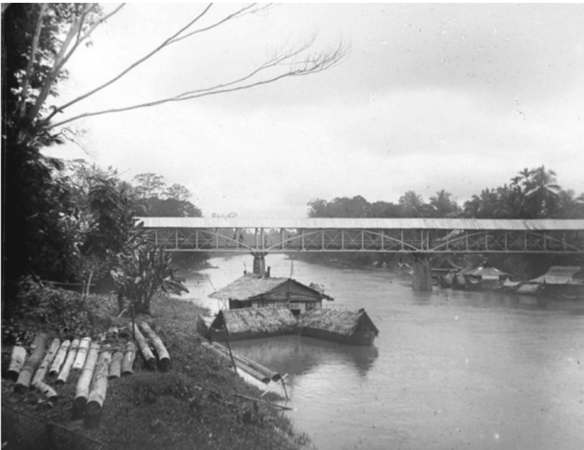
Gambar 48. Sebuah jembatan kayu di atas Sungai Lematang, Muaraenim, Palembang Sumatra Selatan, 1922. Jembatan-jembatan seperti ini banyak dijumpai di kampung-kampung Palembang, dan kondisinya banyak yang rusak parah sehingga menyulitkan warga untuk menyebarang (Sumber: www.tropenmuseum.nl ).
