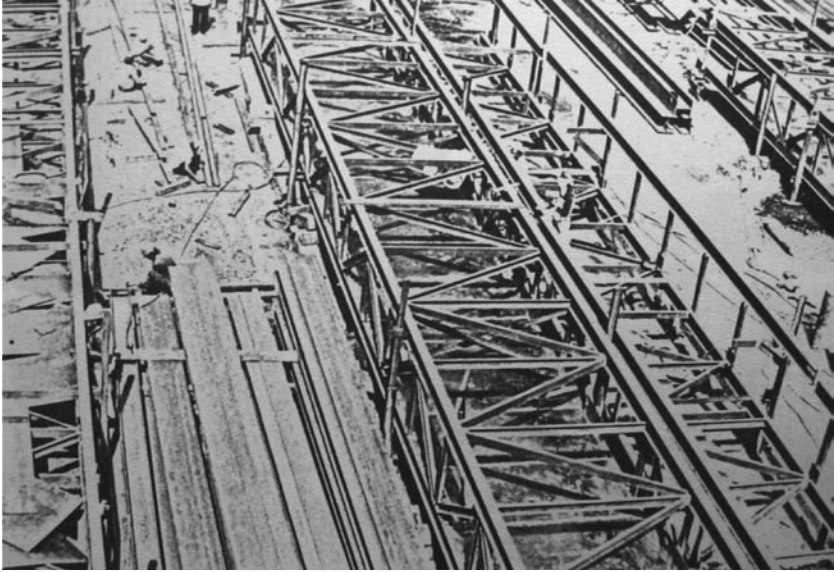
Gambar 50. Kerangka baja Jembatan Musi (Sumber: Koleksi pribadi Bapak Anwar Rifai).
