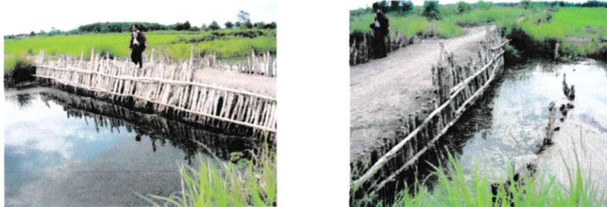
Gambar 7. Bangunan DAM di saluran Sekunder Drainase (SDU) delta Saleh.
