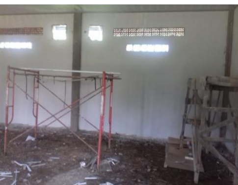
Pekerjaan Ruang kelas
