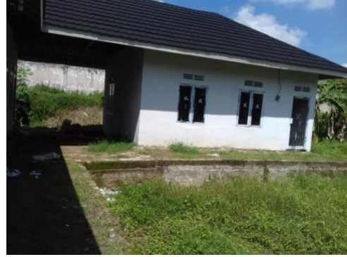
Bangunan sudah pintu dan jendela
