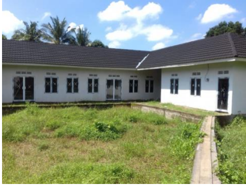
Bangunan sudah pasang atap
