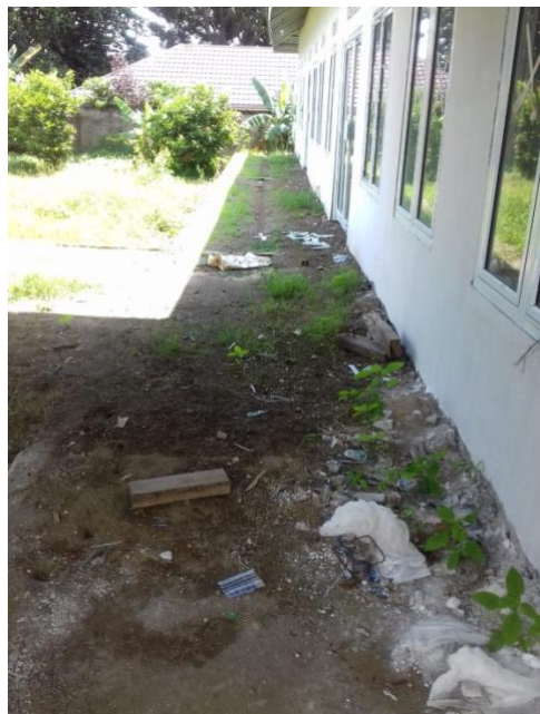
Pekerjaan lantai belum selesai
