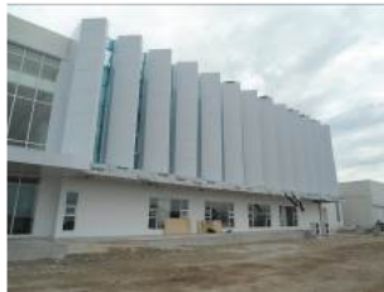
Gambar 10. Penggunaan sirip-sirip ACP sebagai ornamen hias pada bangunan.
