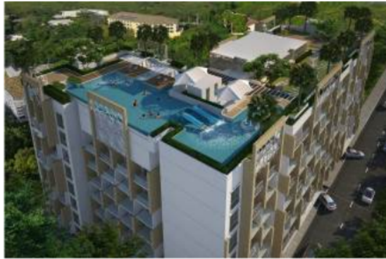
Gambar 11. Perletakkan kolam renang di sebagian roof top akan menimbulkan potensi P Delta effect dan torsion effect .
