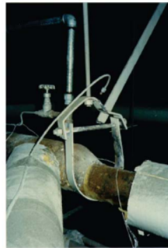
Gambar 4. Kerusakan cabang pipa (sumber : FEMA E-74, 2012)
