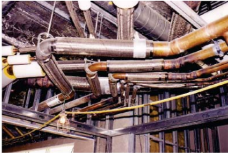
Gambar 8. Koneksi pipa fleksibel antar bangunan terpisah (sumber : FEMA E74, 2012)
