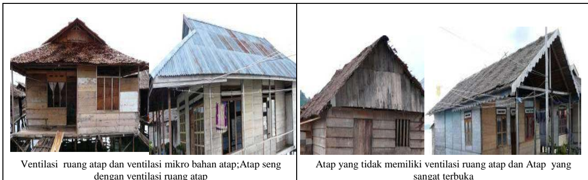
Gambar 6. Bentuk Atap dengan Variasi Ventilasi Ruang Atap dan Mikro Bahan Atap (Sumber: data lapangan, 2009)
