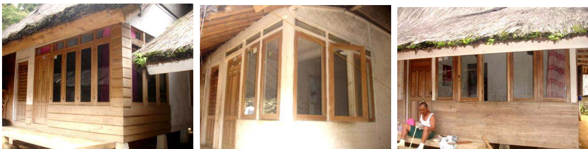
Gambar 7. Jendela pada rumah berpintu dua: bentuk cenderung persegi panjang, jumlah lebih dari satu, didominasi oleh kaca (Sumber: Survai lapangan 2011).
