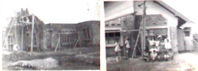
Gambar 5. Foto proses pembangunan rumah
