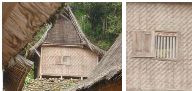
Gambar 6. Jendela pada rumah berpintu satu: bentuk cenderung persegi, jumlah tunggal, terdiri dari daun jendela panil kayu dan jalusi kayu pada lubangnya (Sumber: Survai lapangan 2011).
