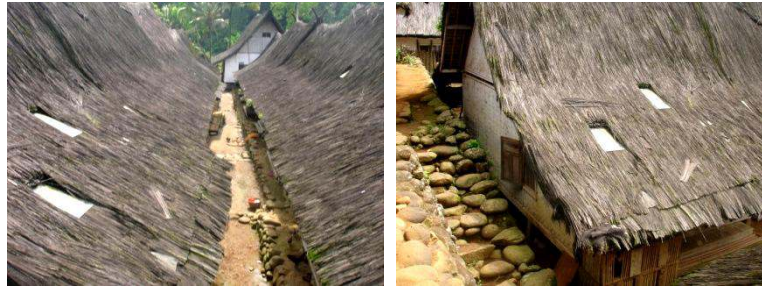
Gambar 8. Penambahan skylight pada atap-atap bangunan rumah tinggal (Sumber: Survai lapangan 2011).
