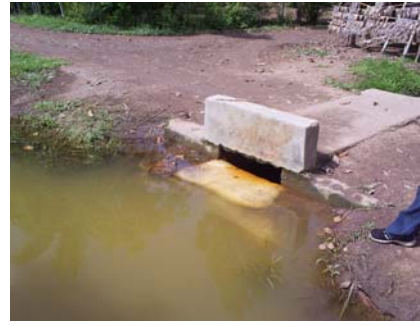
Gambar 36. Bangunan pengendali muka air di saluran tersier lahan tipe C/d di P10-2S Delta Saleh tipe kelep fieber dan stoplog sederhana karung tanah.
