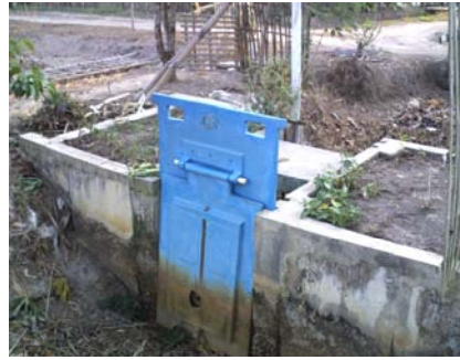
Gambar 36. Bangunan pengendali muka air di saluran tersier lahan tipe C/d di P10-2S Delta Saleh tipe kelep fieber dan stoplog sederhana karung tanah.
