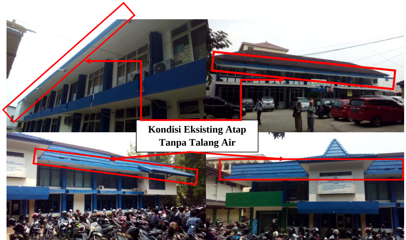
Gambar 4.7. Kondisi Eksisting Atap Kampus FEBI UIN Raden Fatah Palembang
